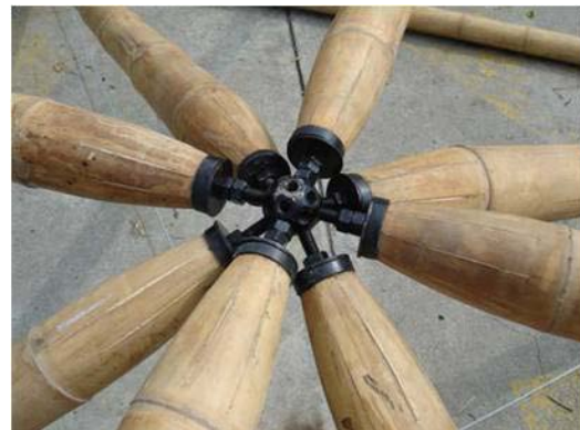
Fig.9: Unión cónica con esfera, J. Stamm
