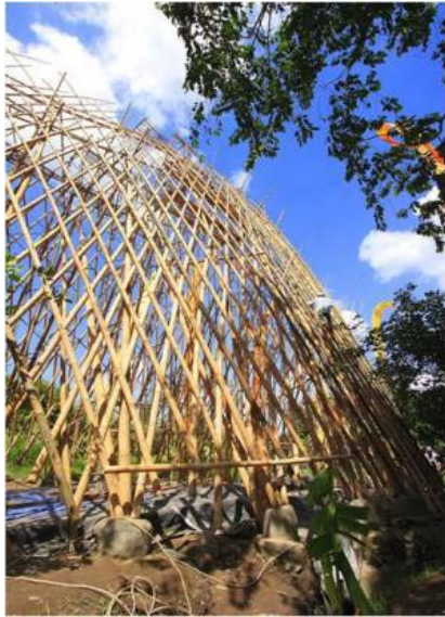
Fig.15: Sistema de Concha con rombos, Bali.
