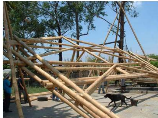
Fig.6: Cercha dos pisos levantando, J. Stamm
