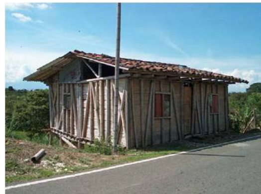
Fig.4: Bahareque degenerado con esterilla
