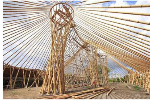
Fig.14: Torres en espiral levantan la "carpa"
